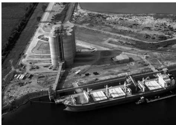
Houston Cement Company: terminale di importazione cemento
