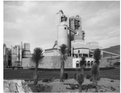
Lo stabilimento di Cerritos in Messico
